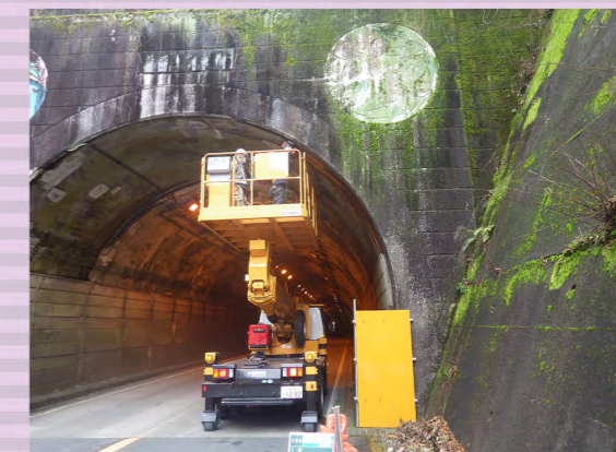
●トンネル内 背面空洞探査
